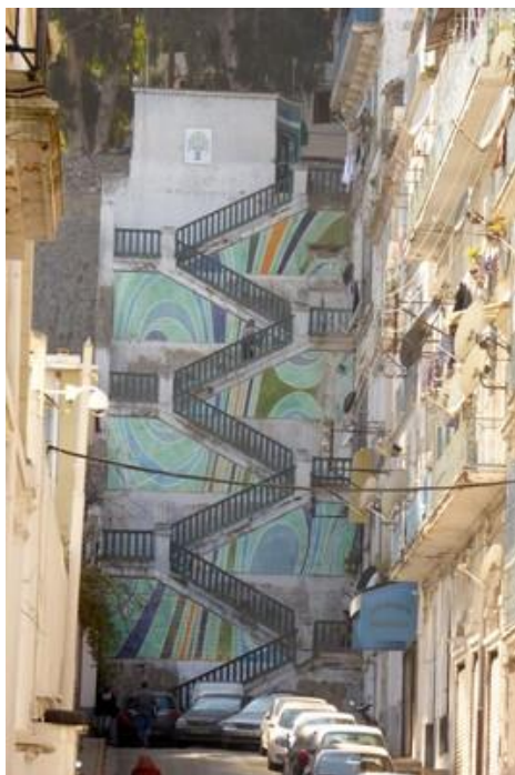
Escalier, quartier français
