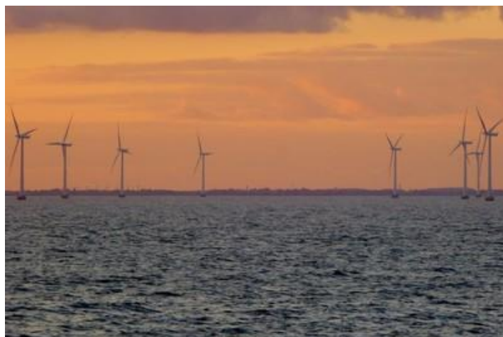
En mer baltique, au nord de l'Allemagne
