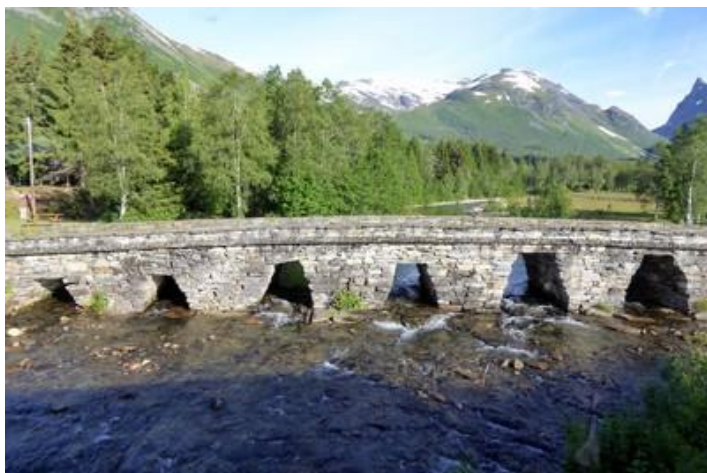
Pont, sur la route de Grodas
