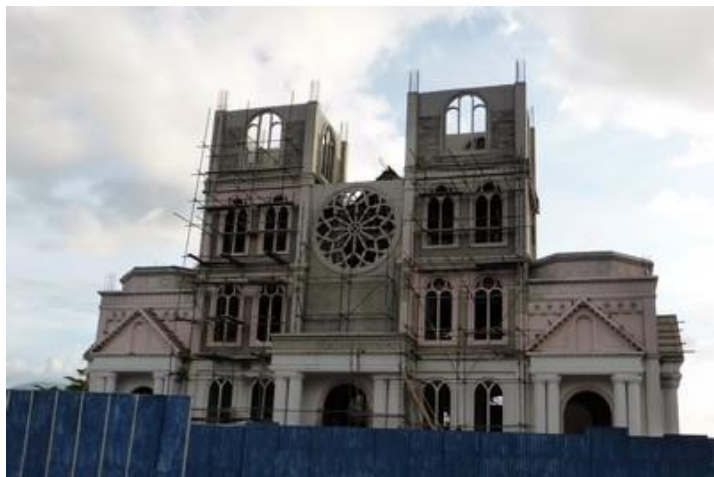
Cathédrale catholique en construction, Apia, Upolu
