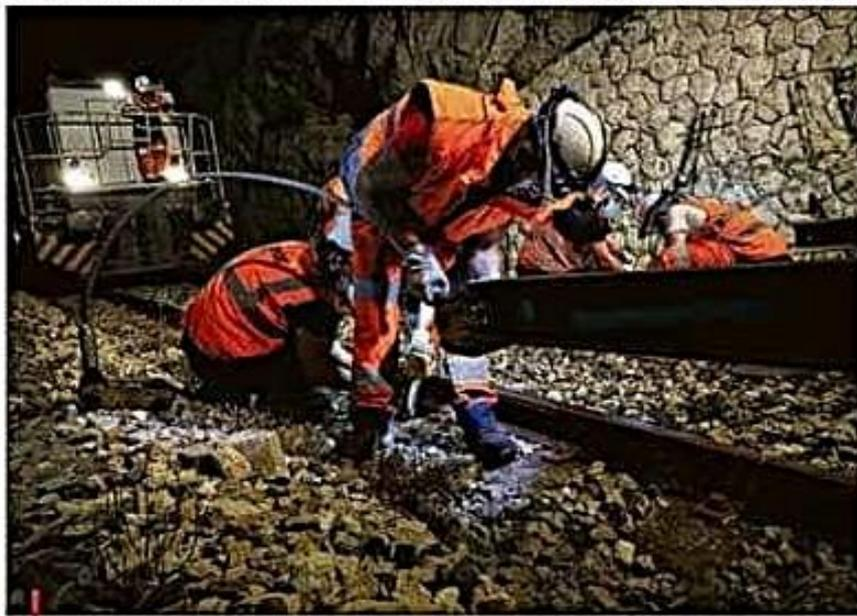
Minuit sur le chantier de la ligne de la Côte bleue. Le rail neuf, à droite, va être mis en place à l'aide d'une étrépe. PHOTOS L.A. / G. BOUTIER
