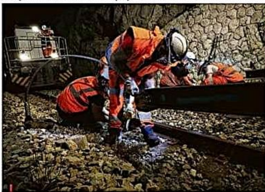
Mise en place du rail neuf, à droite, va être mise en place à l'aide d'une étréole. (PHOTOS: L. G.)
