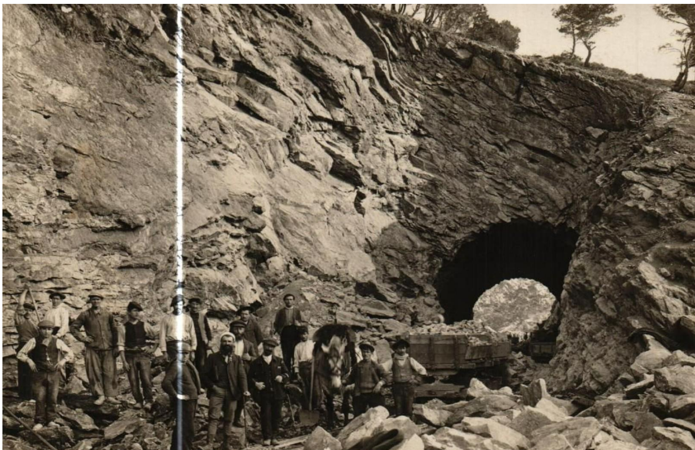
Percement du tunnel de Niolon à la Vesse, vers 1910
