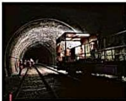
C'est un chantier hors norme qui a débuté, avec la livraison de rails de 108 m de long, provenant d'une ligne TGV. Au milieu, un ouvrier vérifie l'état des voies. À droite, la dépose du nouveau matériel. (PHOTOS L.A.)
