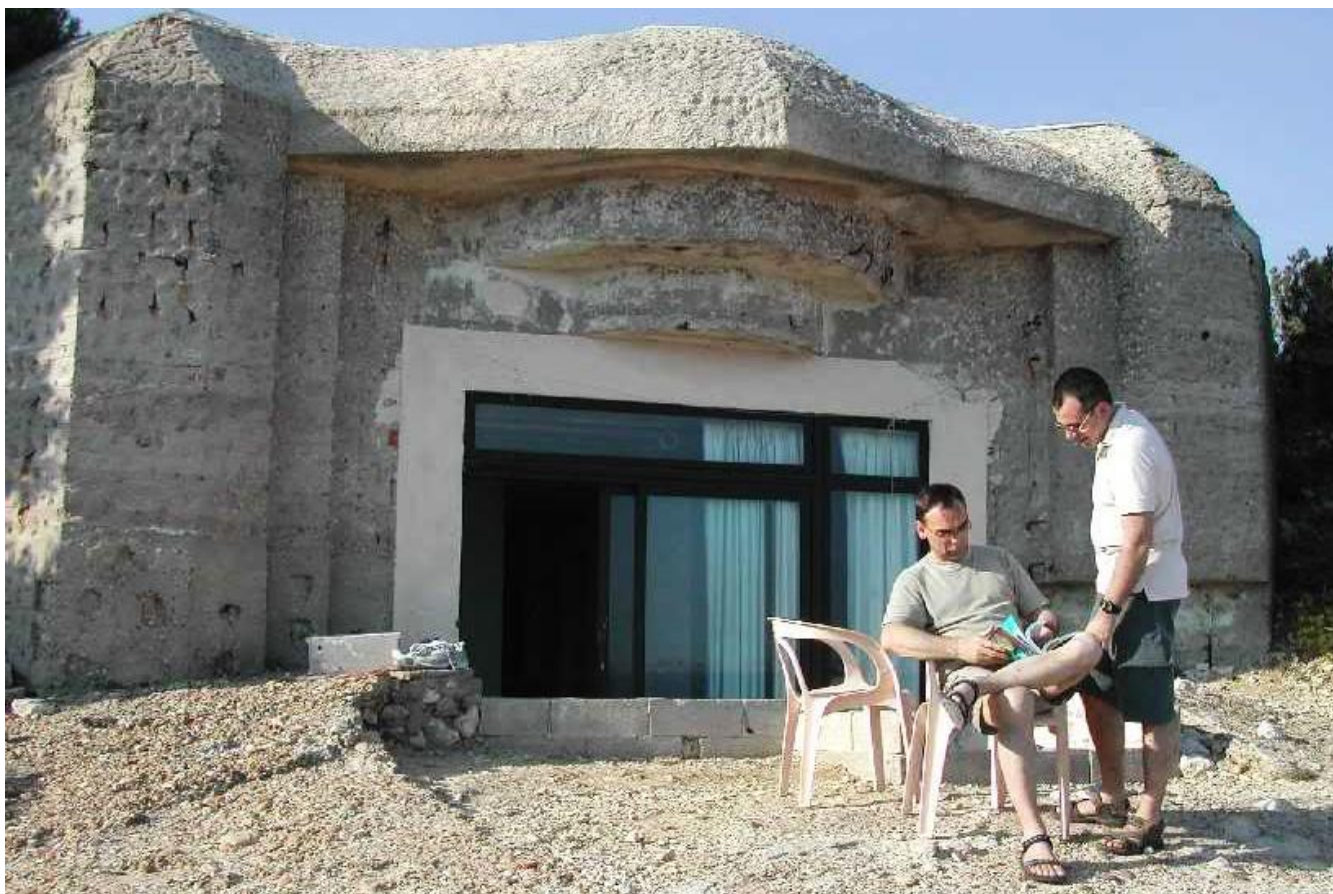
Une des casemates M272 de la batterie allemande de Niolon transformée en chambres de l'UCPA
