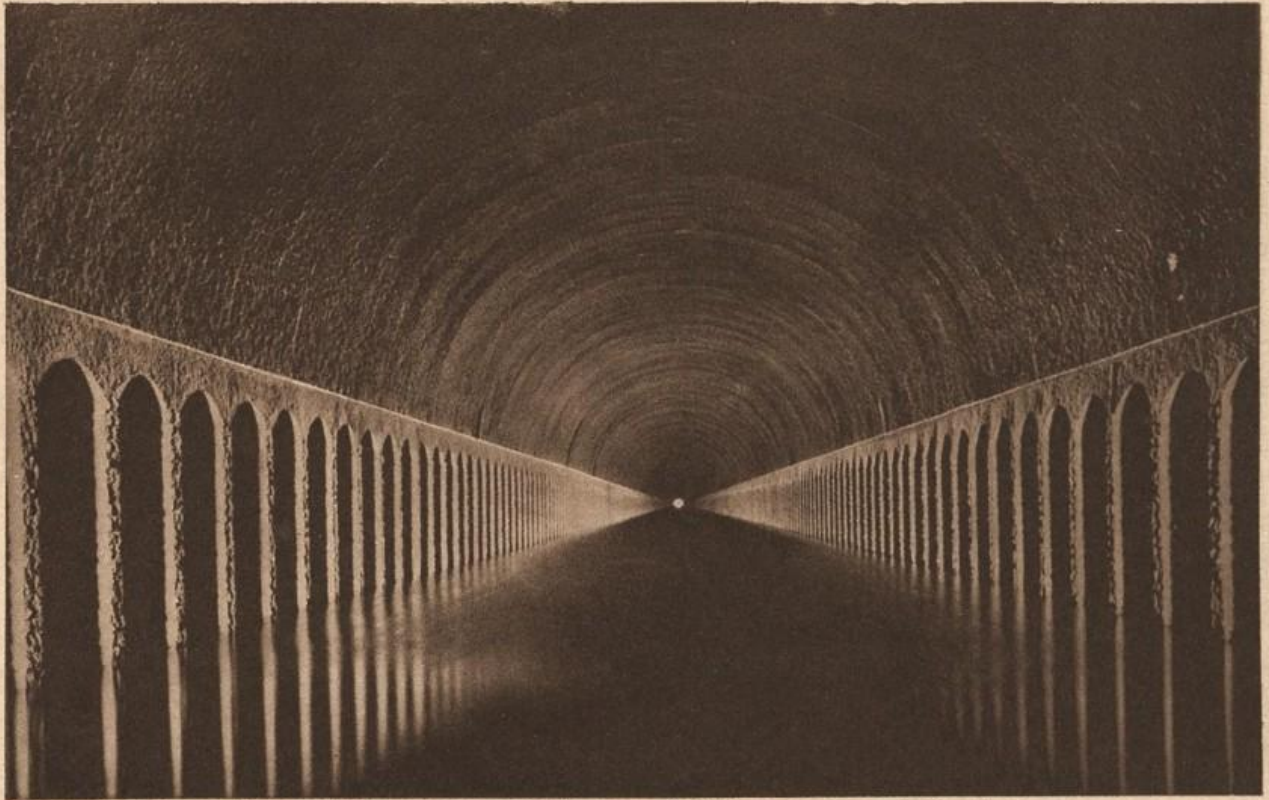
Canal de Marseille au Rhône. — Intérieur du tunnel du Rove. (Vue prise à 200 mètres de la tête nord.). — Le point lumineux est à 7 kilomètres.
