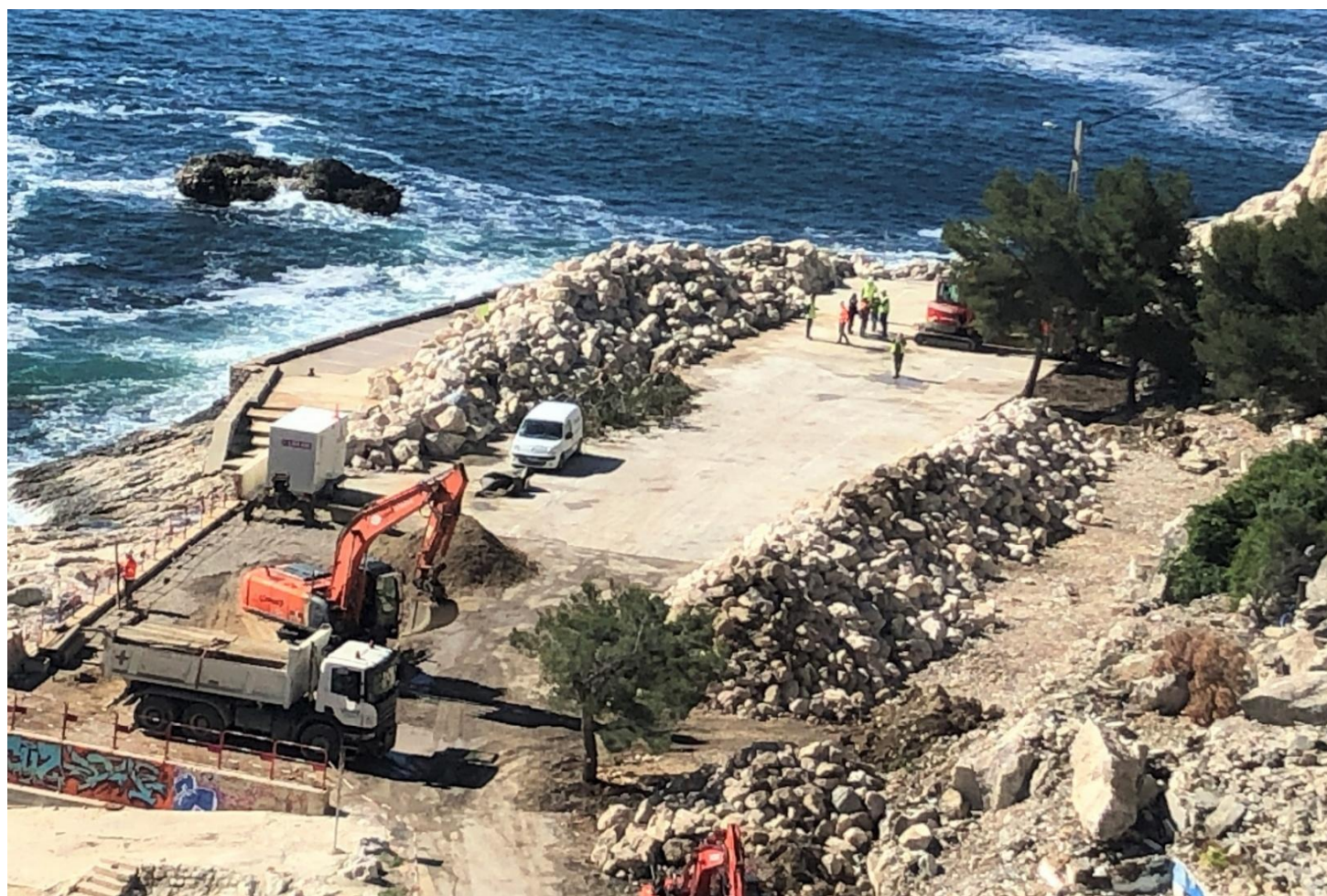
La Vesse durant les travaux, le 12/05/2020
