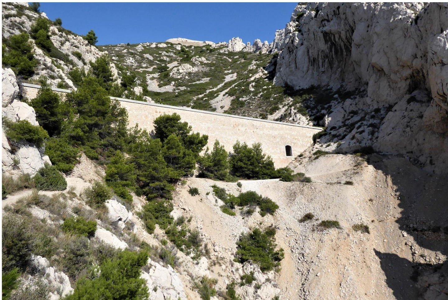
Tunnel ferroviaire du Riflard (photo DF)
