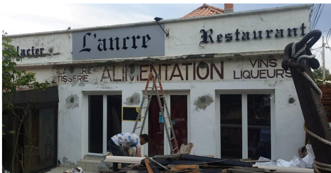
L'Ancre et l'épicerie durant les travaux de rénovation en mai 2020
